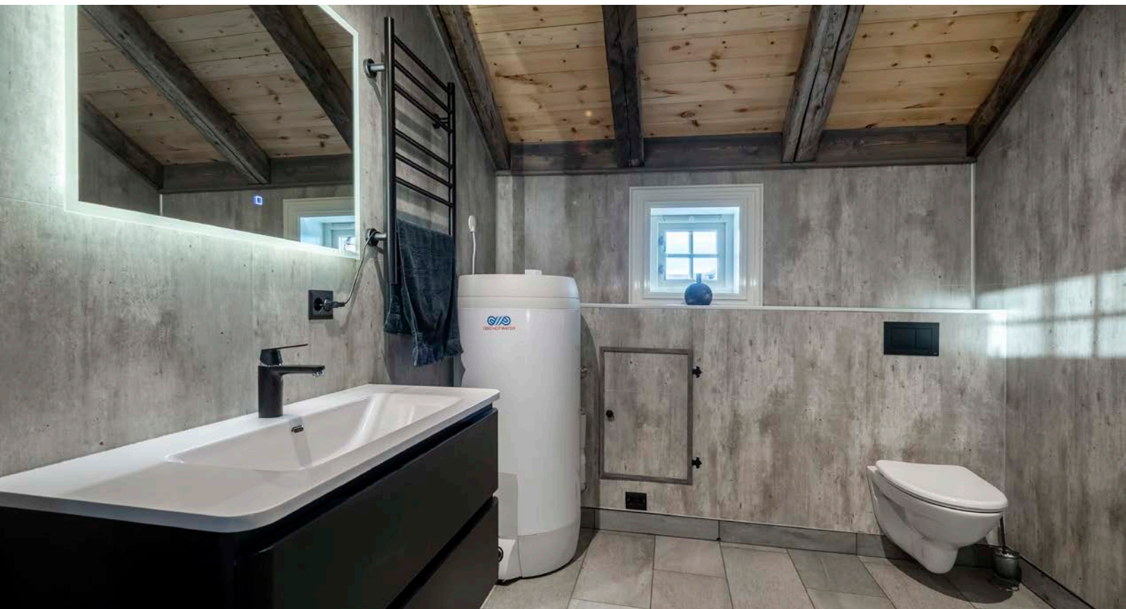
Bad med wc og opplegg for vaskemaskin
