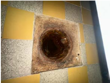
Sluk i soil på bad i 2.etg
