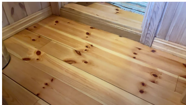
Bad har ikke fuktbestandige materialer og manglende tette sjikt og sluk
