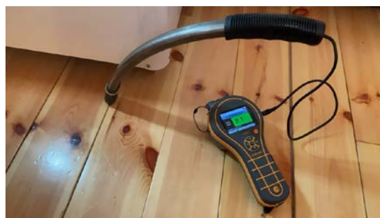
Fuktmåletaking foretatt av gulv inne på badet, uten fuktutslag
