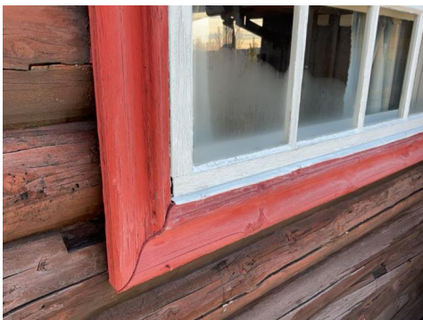
Avvik i innsetningsdetalj og fare for fuktpåvirkning
