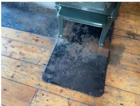
Rust på ubrennbare plater
