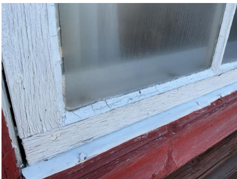
Avvik i innsetningsdetalj og fare for fuktpåvirkning
