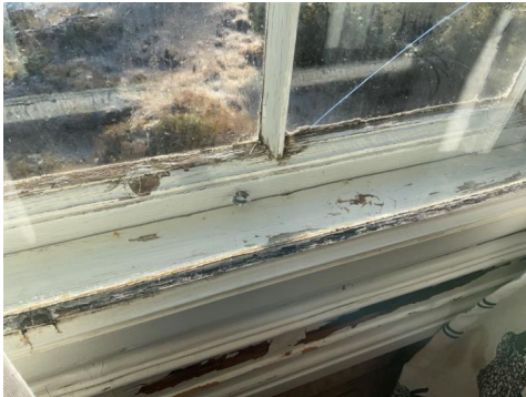
Sprekk i glass, vinduer oppnådd forventet levetid og preget av fukt rundt vinduer
