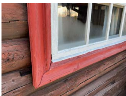
Avvik i innsetningsdetalj og fare for fuktpåvirkning
