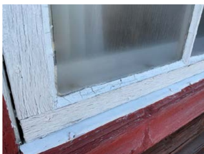
Avvik i innsetningsdetalj og fare for fuktpåvirkning
