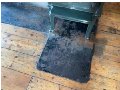
Rust på ubrennbare plater
