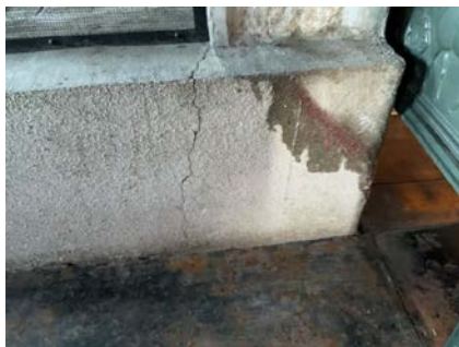
Rust på ubrennbare plater
