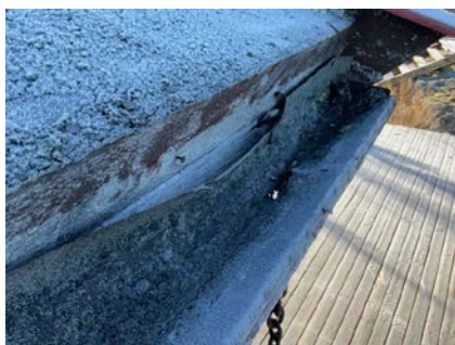
Takrenner har oppnådd forventet levetid
