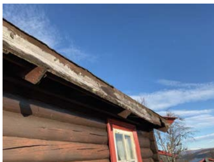
Takrenner har oppnådd forventet levetid
