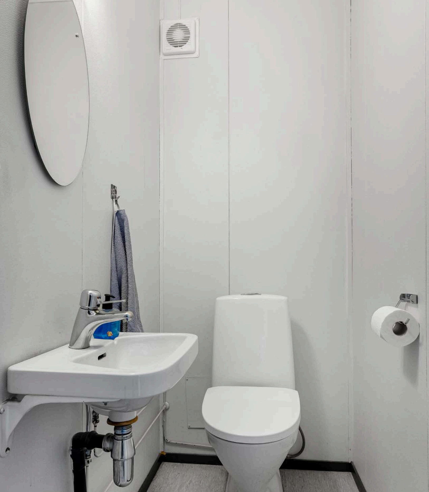
Vegg-i-vegg med baderommet er det et praktisk ekstra toalettrom med avtrekksvifte.
