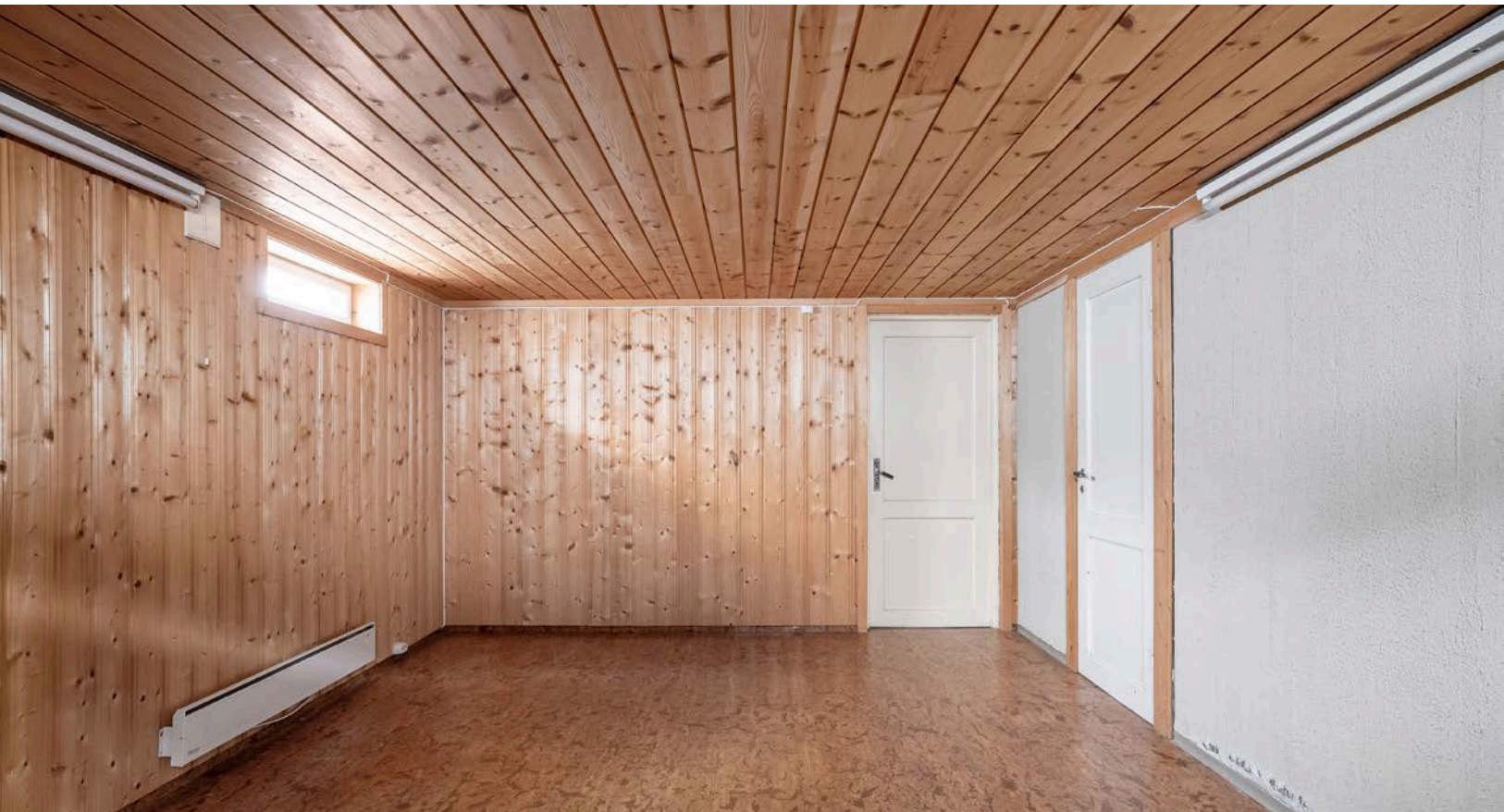
Rom i kjeller innredet som kjellerstue nr 2. Det gjøres oppmerksom på at rommet ikke er godkjent for varig opphold.
