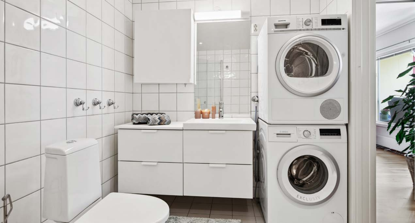
Flislagt bad/vaskerom fra byggeår med plass til vaskemaskin og tørketrommel.
