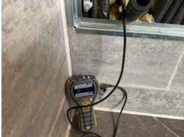
Fuktmåling i vegg ved hulltaking.
