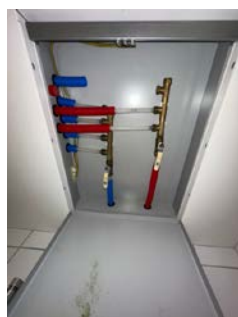
Samleskap med rørkurser og stoppekraner
