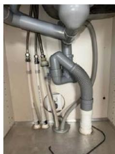
Samleskap med rørkurser og stoppekraner
