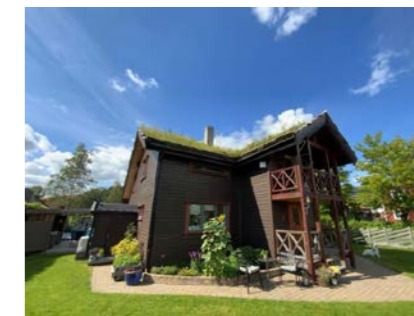
Besiktigelse av taktekke.
