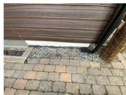
Kontroll av drenering/fuktsikring.
