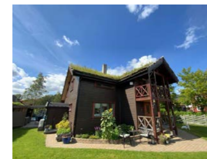
Besiktigelse av taktekke.
