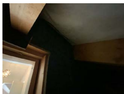
Kontroll av undertak i raftekott.
