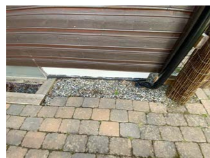
Kontroll av drenering/fuktsikring.
