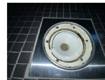
Kontroll av sluk.
