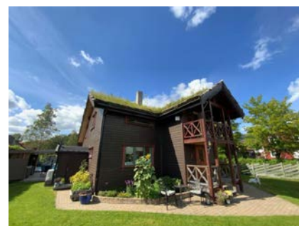
Besiktigelse av taktekke.
