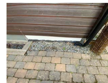
Kontroll av drenering/fuksikring.
