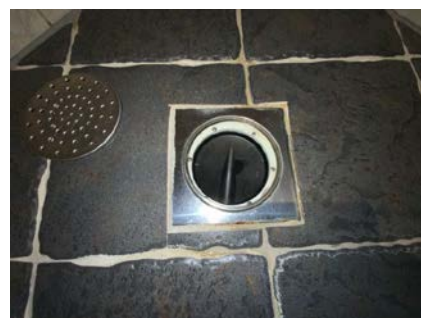
Kontroll av sluk.
