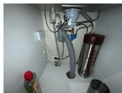
Besiktigelse av røropplegg.
