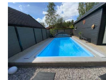
Besiktigelse av basseng.
