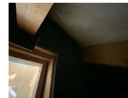
Kontroll av undertak i raftekott.
