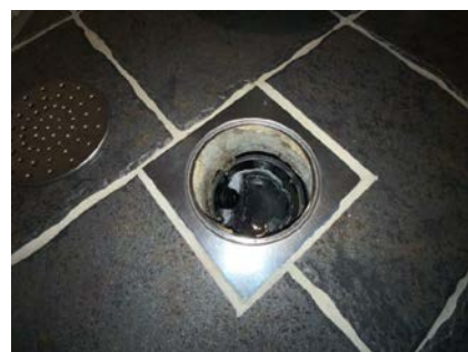
Kontroll av sluk.
