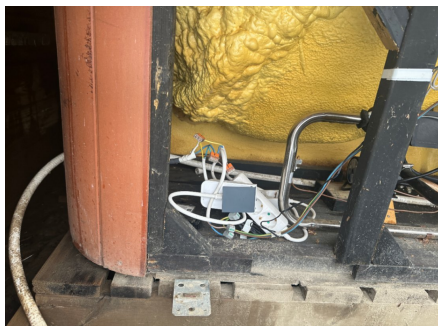
Utvendig kobling av Jacuzzi
