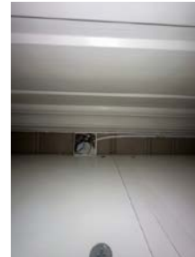
Manglende deksel over kjøkken
