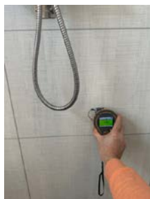
Fuktmåling med moderate resultater
