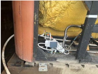
Utvendig kobling av Jacuzzi
