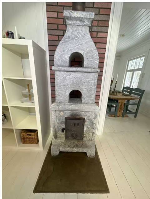
Viser klebersteinsovn i stue med toppmontert røykgassrør.
