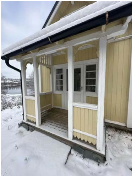
Viser overbygget terrasse med adkomst fra stue og terreng.
