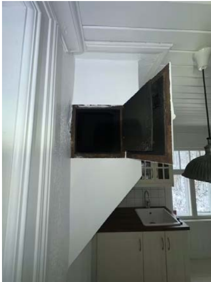
Sotluke plassert i kjøkken.
