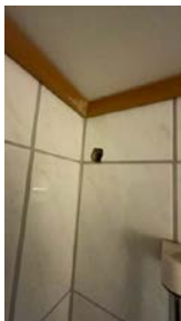
Avløpsrør høyt på vegg i dusjsone.
