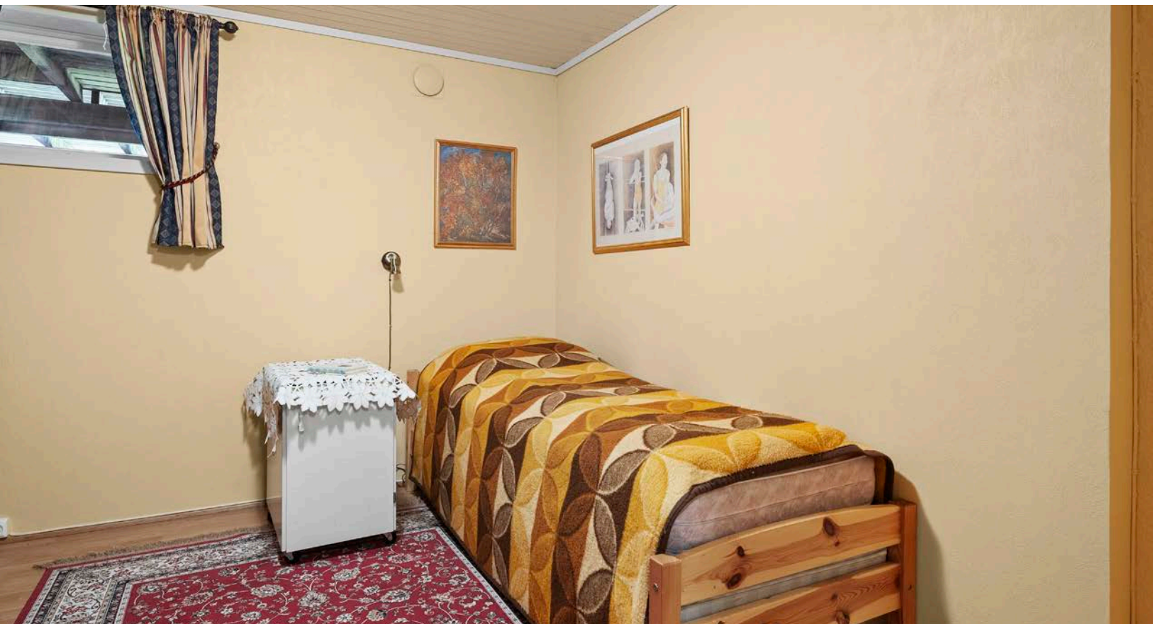
Ett av tre rom innredet som soverom i underetasjen (ikke byggesøkt og ikke godkjent rømningsvei)
