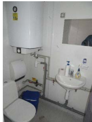
Del av våtrommet med sanitærinstallasjoner.
