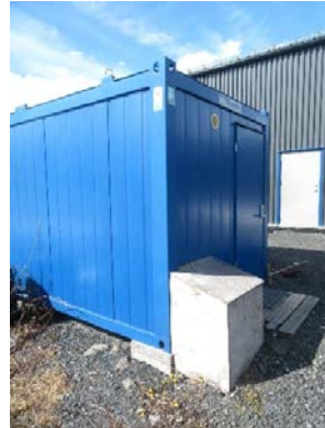
Utv. innkassing av vann og avløpsrørene tilknyttet offentlig anlegg.
