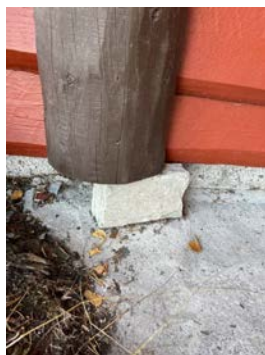
Ufagmessig understøtting av søyler
