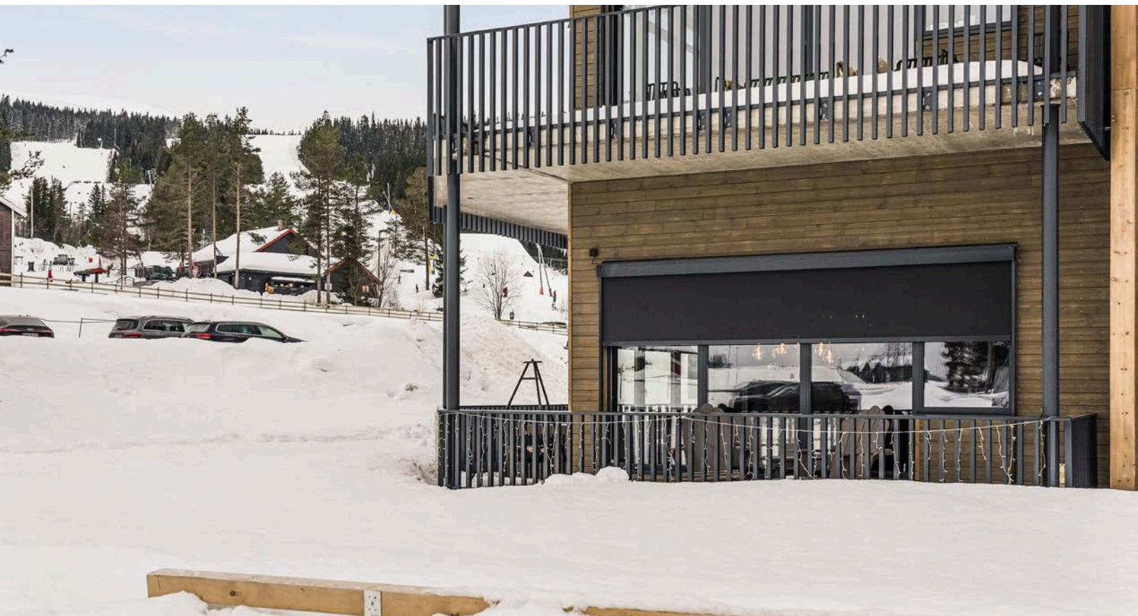
Utvendige screens på alle vinduer (solcellestyrt).
