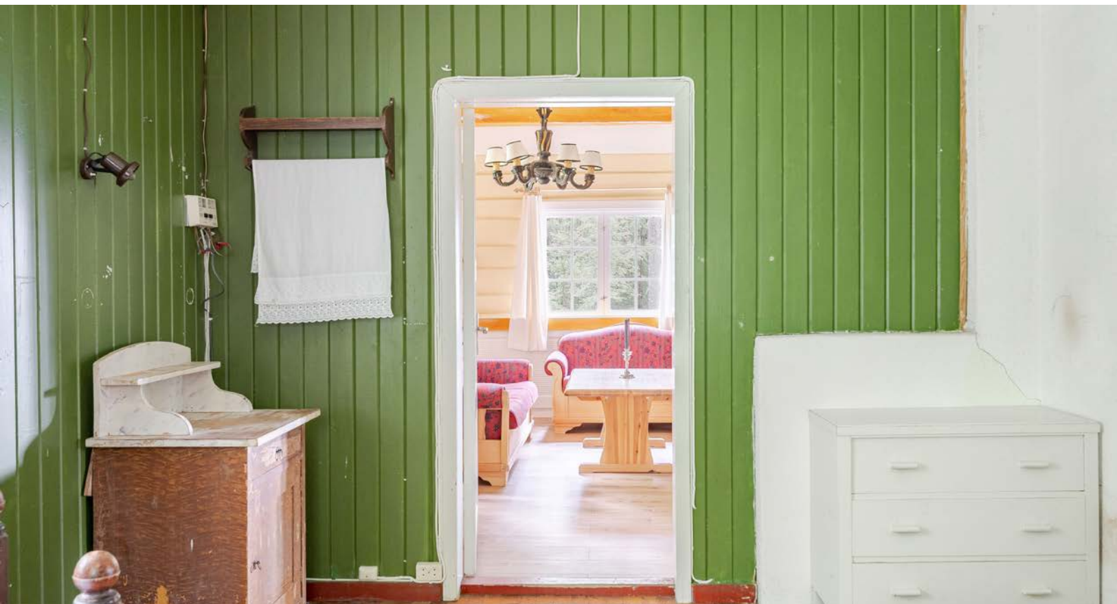
Hytta har 12 V solcelleanlegg med solcellepanel plassert mot vest. Regulator er plassert på soverom. 230 V via bensinaggregat plassert i tilbygg mot nord. Synlige strømledninger til alle oppholdsrom.
