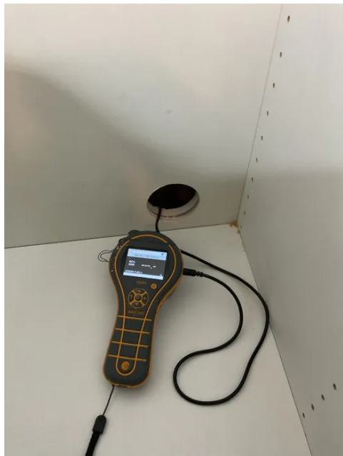
Hulltaking i tilstøtende rom.
