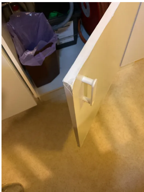
Skade på innrdning.
