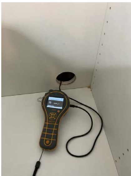
Hulltaking i tilstøtende rom.
