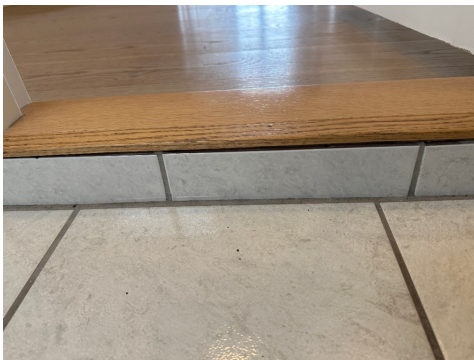
Overgang mot dørterskel.
