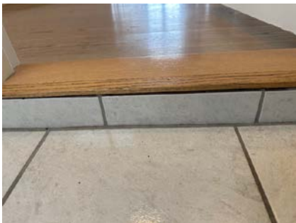
Overgang mot dørterskel.
