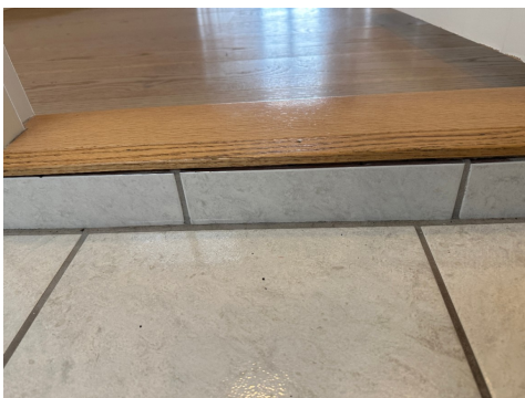
Overgang mot dørterskel.
