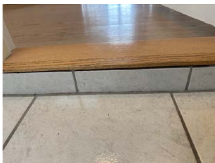
Overgang mot dørterskel.
