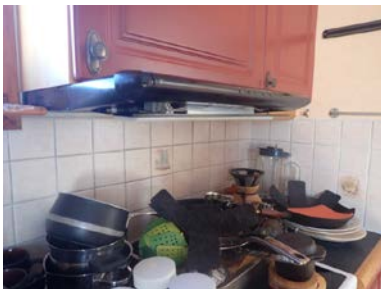
Skade i kjøkkenventilator.
