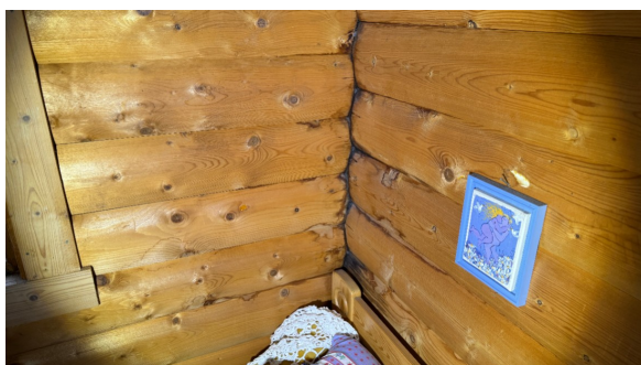
Det er registrert råteskader i enkelte stokker.
