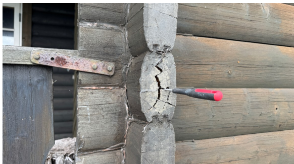
Det er registrert råteskader i enkelte stokker.
