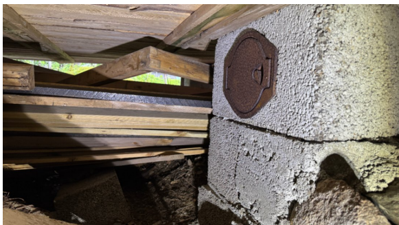
Kontroll av sotluke.
