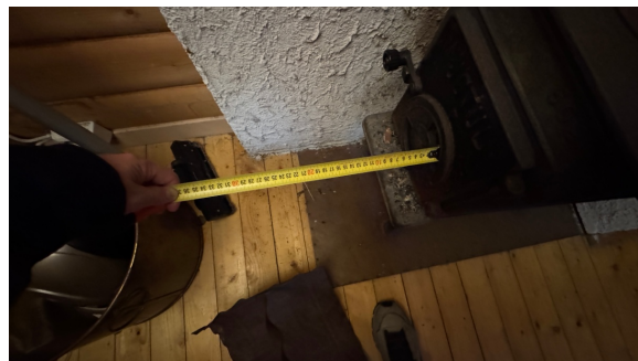
Kontroll av ildfast plate under vedovnen.
