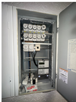
Sikringskap med originale skrusikringer
