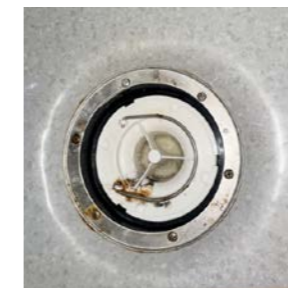
Sluk i plast, plassert i dusjnisje
