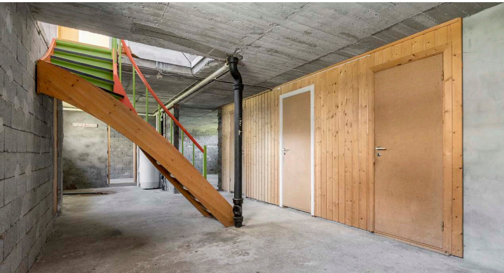
Rommet har støpte gulv og murvegger og dører til forskjellige boder.
