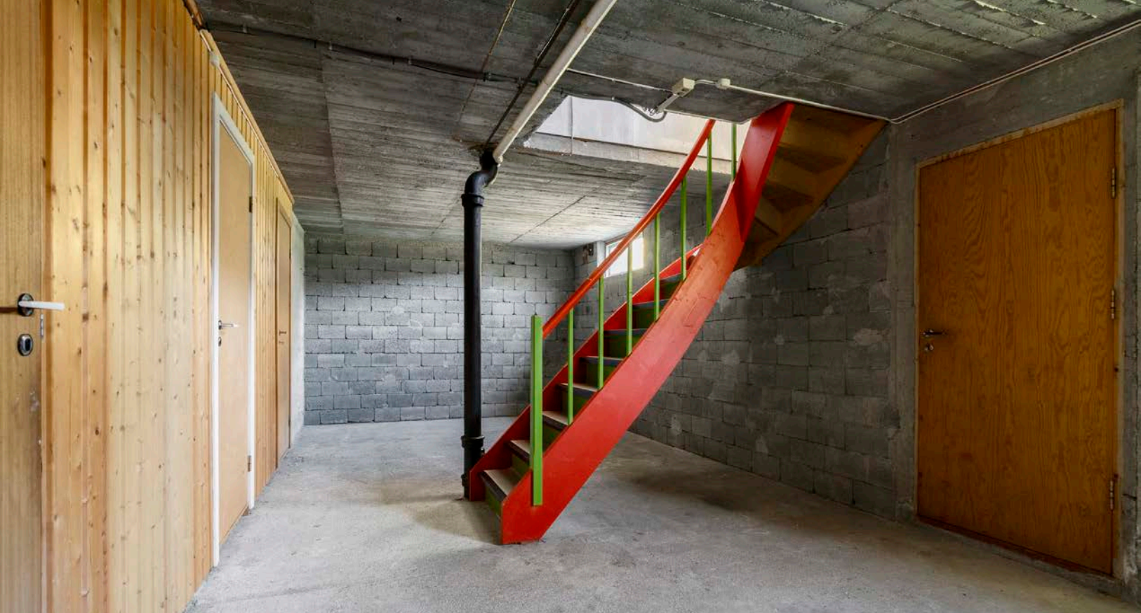
Det største kjellerrommet har dør ut til terreng.
