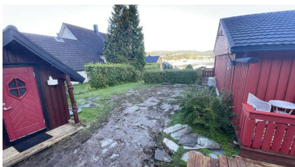
Like før befaringen er det etablert ny vannledning inn til boligen
