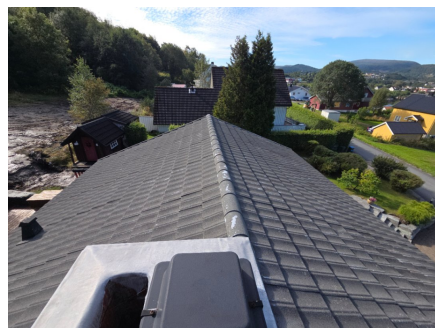
Oversikt tak sett fra pipe
