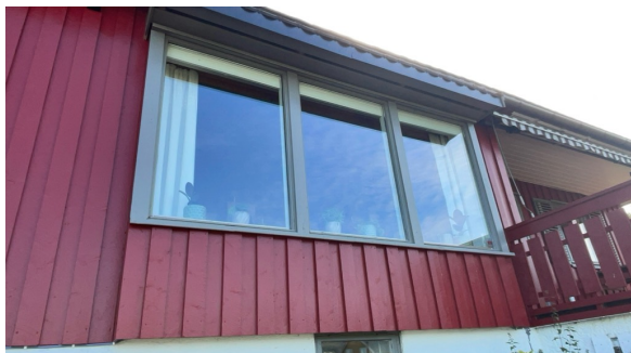
Vinduer på stue
