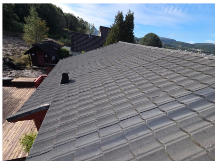
Oversikt tak sett fra pipe
