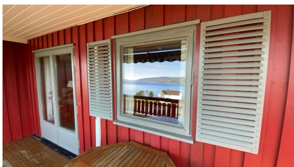
Vindu på soverom 4
