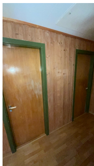
Dører til soverom 3 og soverom 2 sett fra gang
