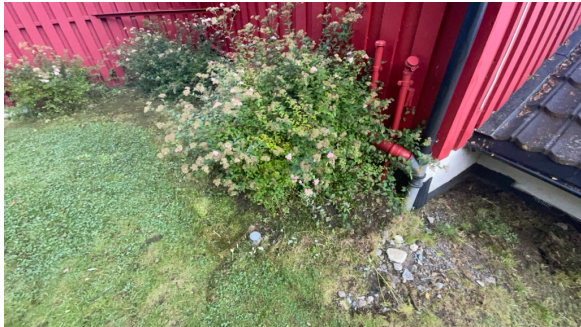
Synlige påfyllingsrør på baksiden av boligen
