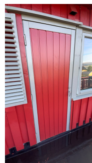
Balkongdør med utgang fra soverom
