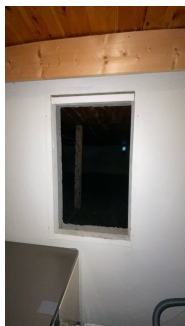
Luke til krypkjeller/kryprom sett fra teknisk rom/vaskekjeller
