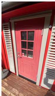
Inngangsdør i 1. etasje fra 2009. Solbleket.
