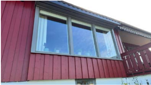
Vinduer på stue
