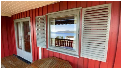
Vindu på soverom 4
