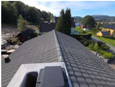
Oversikt tak sett fra pipe
