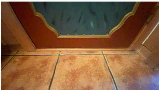
Tilluft til toalett via hull i dør
