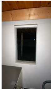
Luke til krypkjeller/kryprom sett fra teknisk rom/vaskekjeller
