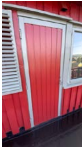
Balkongdør med utgang fra soverom
