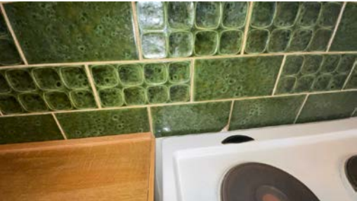
Skade på ei flis. Sprekk i flisfuger og bom ved overgang mellom mur og pipe bak komfyr.
