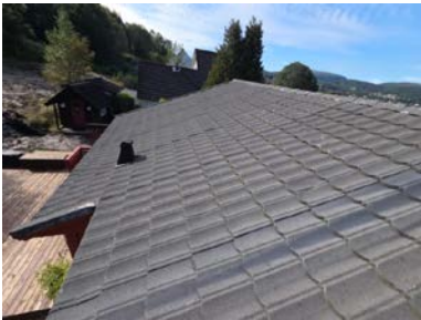
Oversikt tak sett fra pipe
