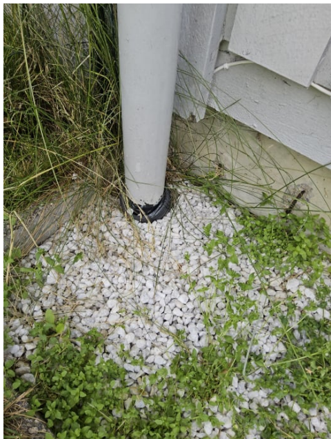
Bilde viser taknedløp ført ned i drensør.
