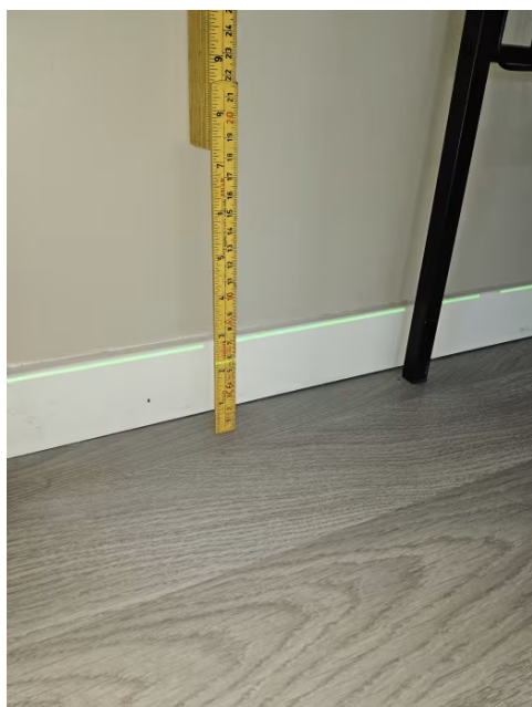
Bilde viser måling av etasjeskiller.
