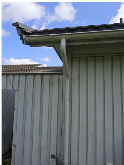
Bilde viser takrenne og nedløp.
