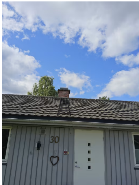
Bilde viser takstige.
