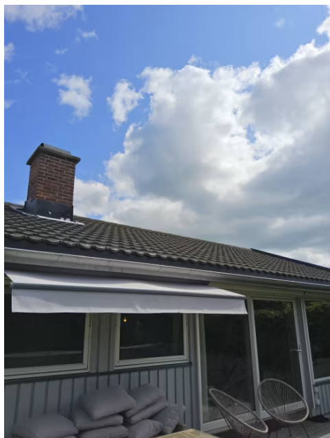
Bilde viser taktekking.
