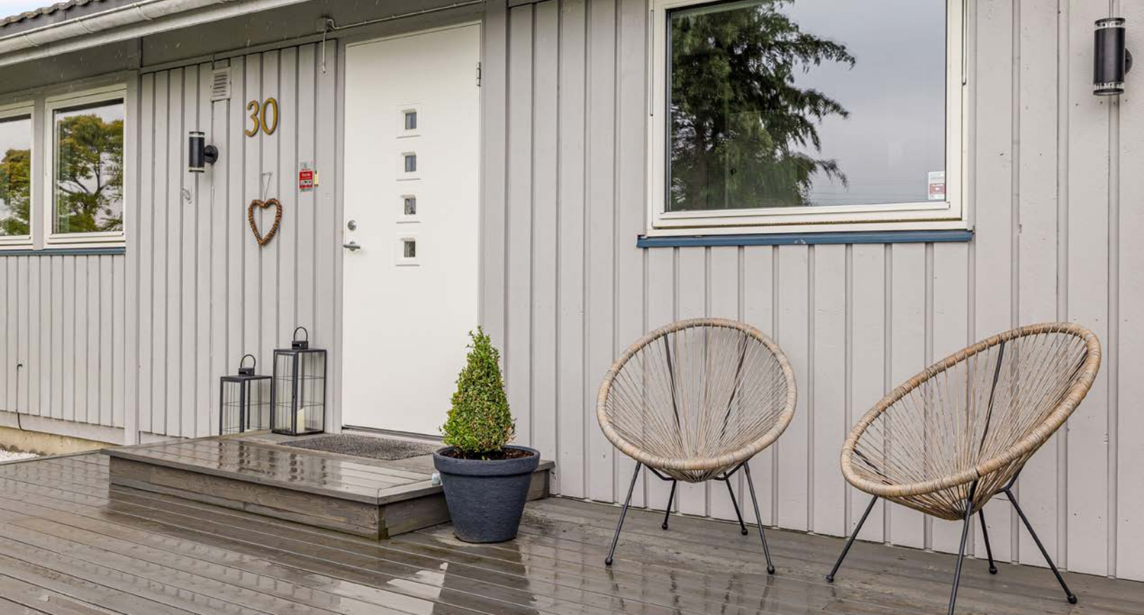
Terrassen ved inngangspartiet er bygget i 2021.
