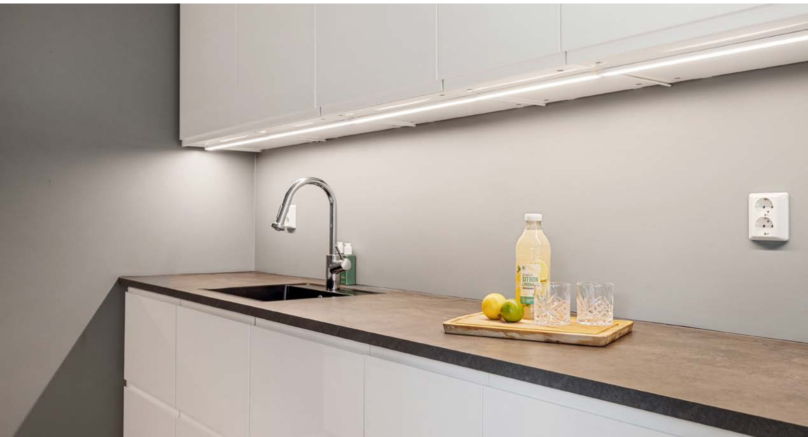
Det er god belysning med lyslist under overskapene.
