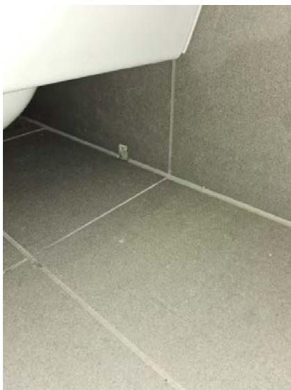
Bilde viser dreneingsspalte for innebygget toalettsisterne.
