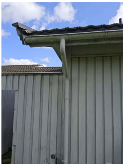
Bilde viser takrenne og nedløp.
