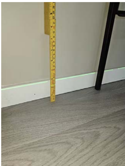
Bilde viser måling av etasjeskiller.
