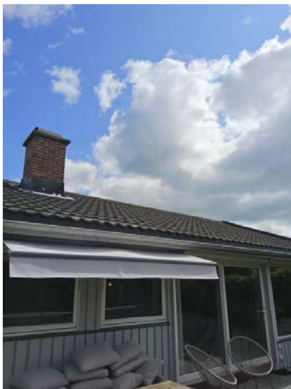
Bilde viser taktekking.
