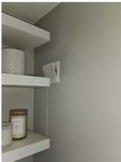
Bilde viser klaffventil på yttervegg.
