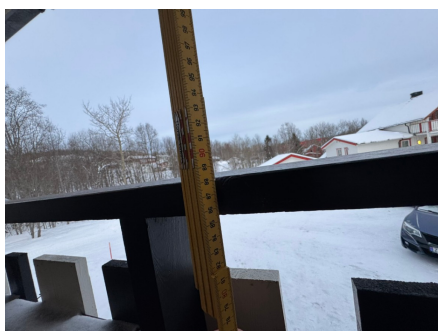
Høyden på rekkverket.
