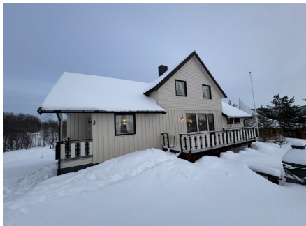
Manglende snøfangere ved trappen til altanen.
