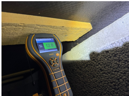
Fuktmåling i krypekjelleren.
