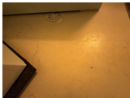
Eksempel på utettheter.
