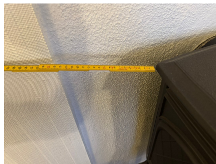
Avstand til brennbart materiale.
