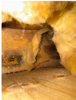
Innvendig i vegg mot vaskerommet.
