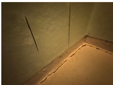
Eksempel på utettheter.
