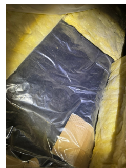
Plast/dampsperre mellom isolasjonslagene.
