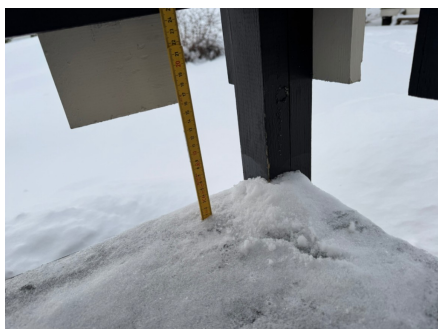
Åpninger i rekkverket.
