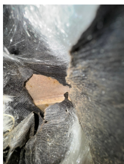
Innvendig i veggen hvor hulltakingen er foretatt.
