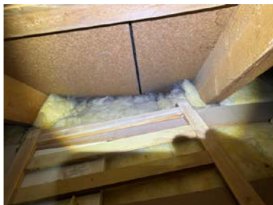
Eksempel på lite lufting.
