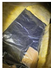
Plast/dampsperre mellom isolasjonslagene.
