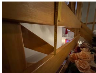
Eksempel på for store åpninger i trappen.
