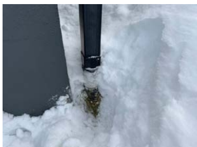
Nedløp ført ned i bakken i rør.
