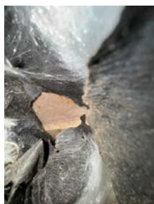
Innvendig i vegg hvor hulltakingen er foretatt.
