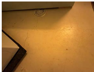
Eksempel på utettheter.
