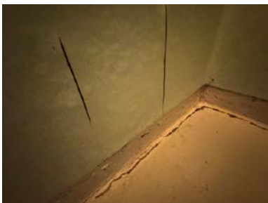
Eksempel på utettheter.
