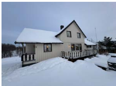
Manglende snøfangere ved trappen til altanen.
