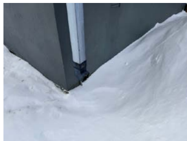
Nedløp avsluttet over terreng med utkaster.
