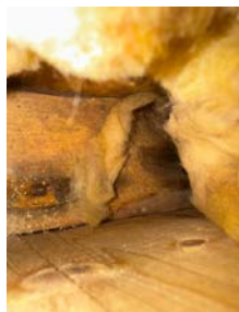
Innvendig i vegg mot vaskerommet.
