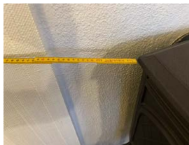
Avstand til brennbart materiale.
