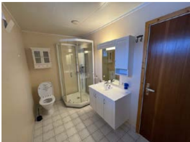
Badet i 1. etasje med plater på veggene.
