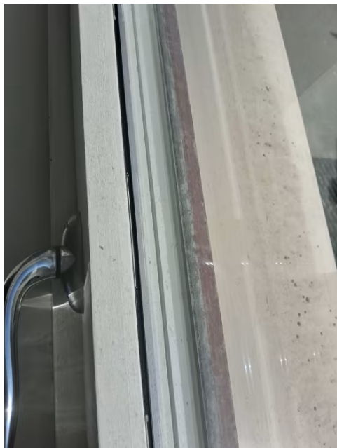
Leiligheten har vinduer med tre-lags glass.
