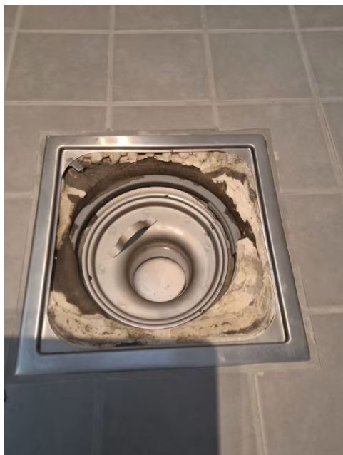
Ingen synlige avvik i sluk.
