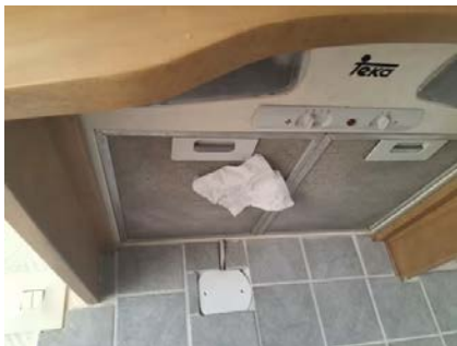
Kjøkkenventilator er testet med papir.
