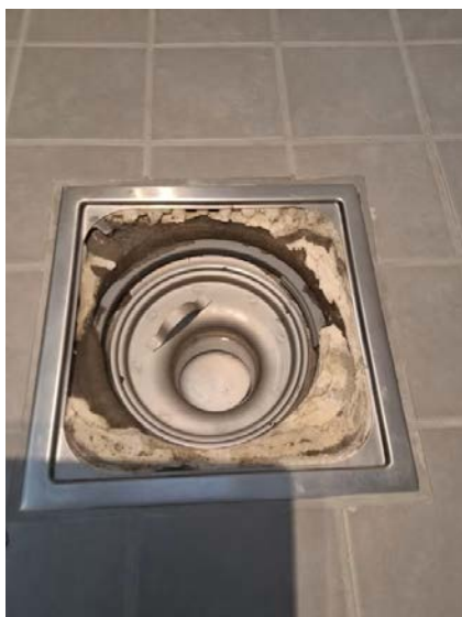
Ingen synlige avvik i sluk.
