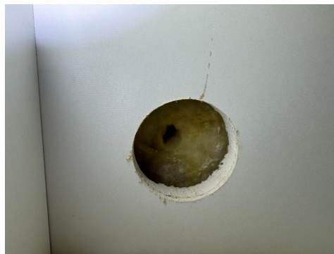
Synlig del av veggkonstruksjon etter hulltaking.
