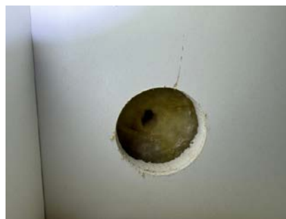
Synlig del av veggkonstruksjon etter hulltaking.
