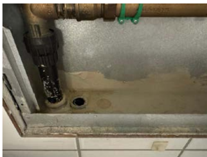
Bunn i rør i rør skap er smurt med membran/tettesjikt.
