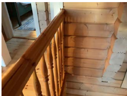
Anbefales innfesting av rekkeverk
