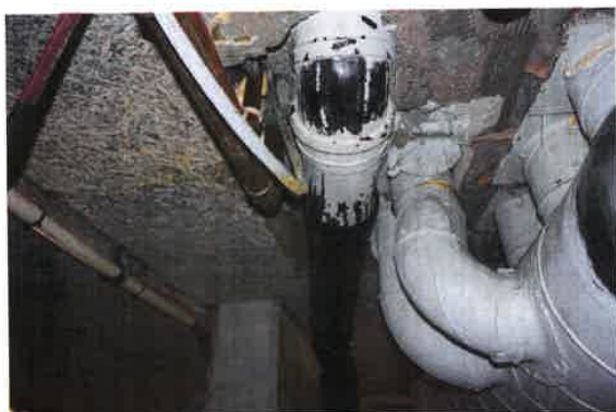
Det er tatt hull i etasjeskille, skummet med byggsaum ved gjennomføring.
