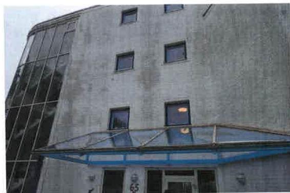
Baldakin med eloksert aluminium og glass, bør vaskes.
