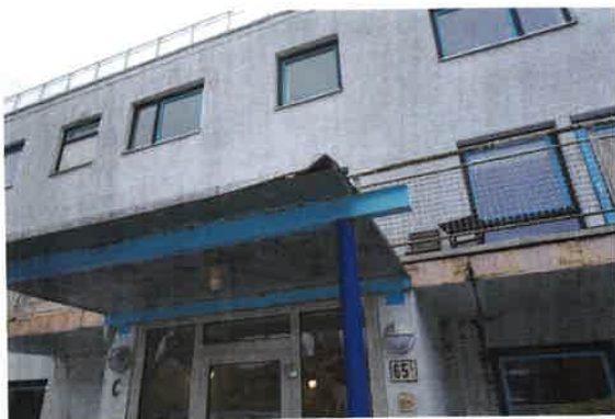
Mye avflassing på undersiden baldakin.
