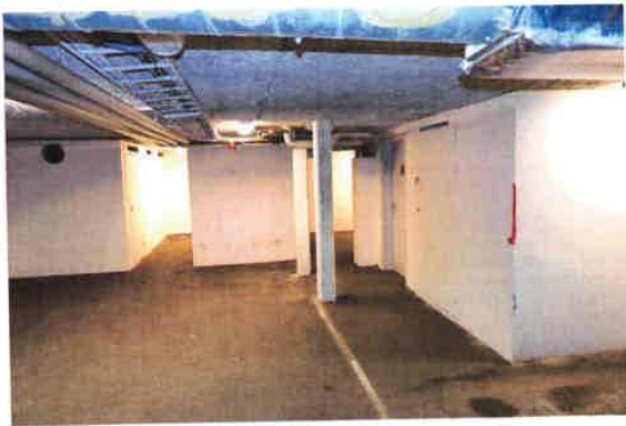
Bærevegger og søyler i betong uten tegn til nedsatt funksjon ellert større sprekker.
