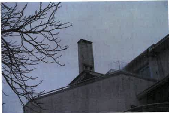
En av pipene i sameiet, overflatebehandling er medtatt under fasadeprosjektet.
