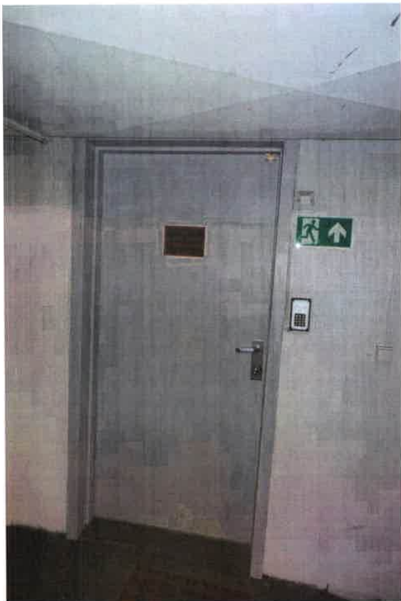
Branndører av overflatebehandlet stål.
