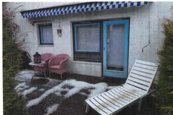
Vegger er på utvendig side pusset og overflatebehandlet.
