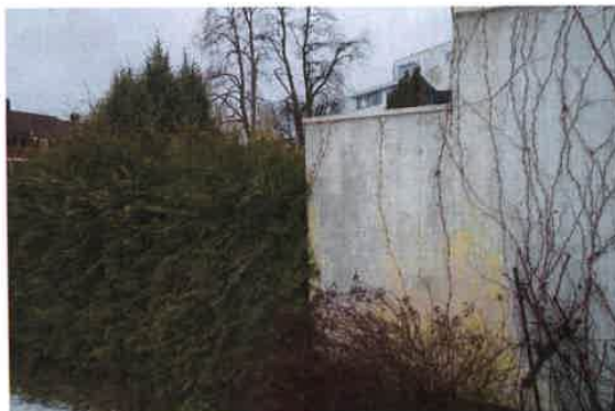
Vegetasjon mot fasade.
