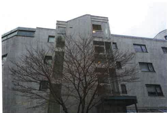
Vegetasjon mot fasade.
