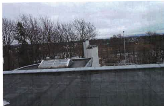
Taket har flere nivåer, viktig med takkontroll.
