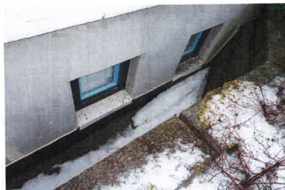
Grunnmursplast med topplist, dren spyles.
