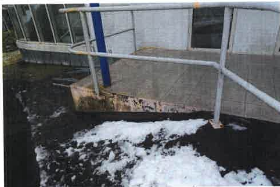
Grunnmursplast med topplist, dren spyles.
