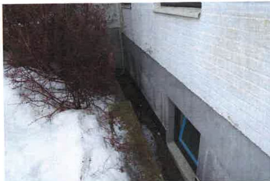
Grunnmursplast med topplist, dren spyles.
