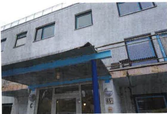
Mye avflassing på undersiden baldakin.
