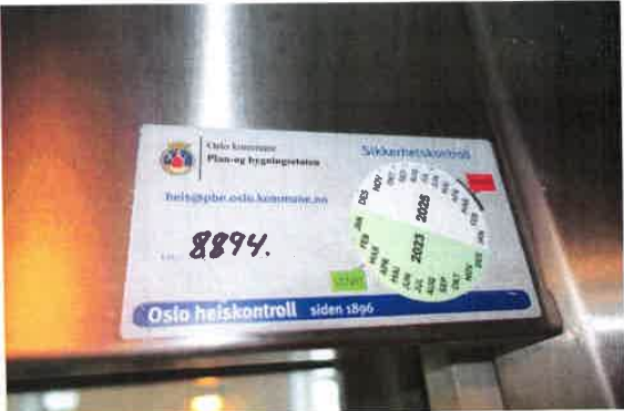
Merke fra forrige sikkerhetskontroll.
