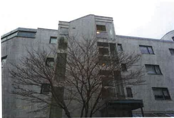
Vegetasjon mot fasade.
