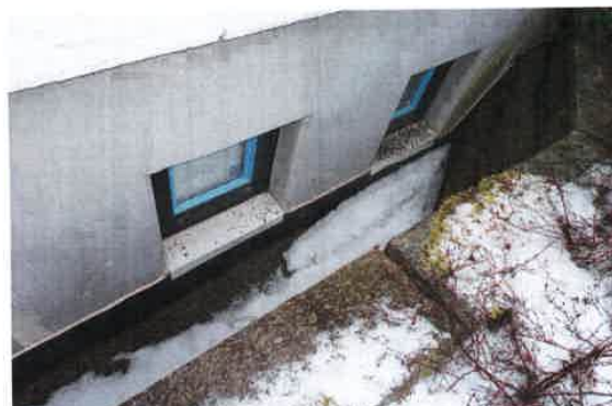
Grunnmursplast med topplist, dren spyles.
