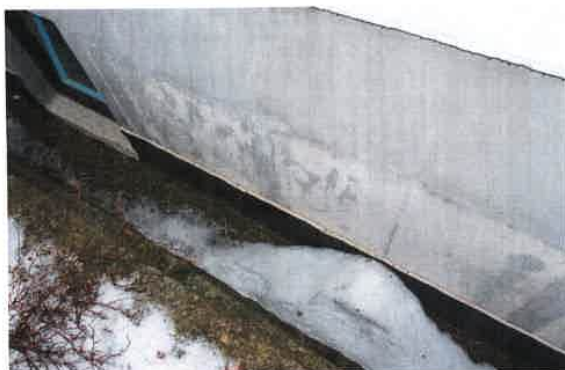
Grunnmursplast med topplist, dren spyles.
