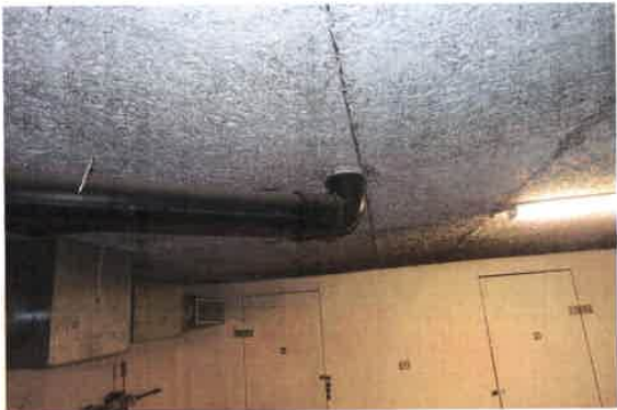
Tresonitt som isolasjon underside etasjeskille i kjeller.
