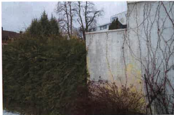
Vegetasjon mot fasade.
