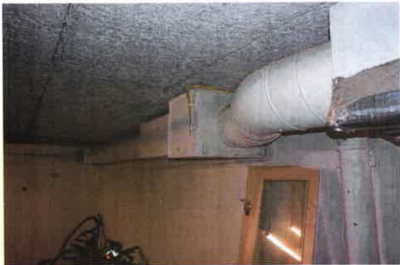
Tresonitt som isolasjon underside etasjeskille i kjeller.
