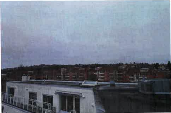
Deler av bygget takkonstruksjon.
