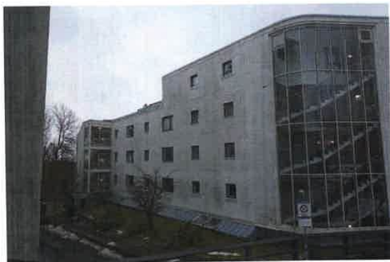
Byggets fasade med trapperom og glassfasader.
