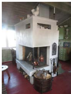
Gruepeis i stue - vedovn på kjøkkenside.
