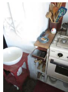
Sotluke antas montert bak unerskap - ikke lovlig løsning.
