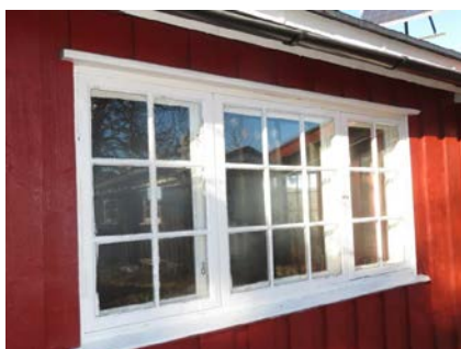
Doble vinduer fra byggeår.
