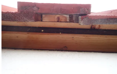
Oversiktsbilde oppunder kledning.
