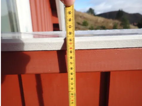
Rekkverkshøyde.
