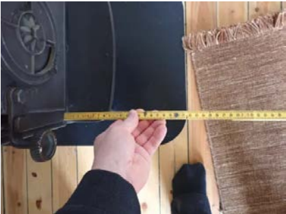
For kort ubrennbar plate på gulv foran ovn.
